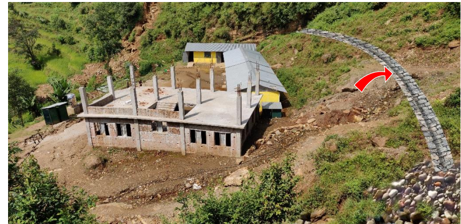
चित्र नं. १: भिरालो जमिनमा सठभावित खहरेबाट बच्ने ड्रेन बनाउने
